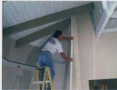
Anlegen des Profils an einer Außenecke
