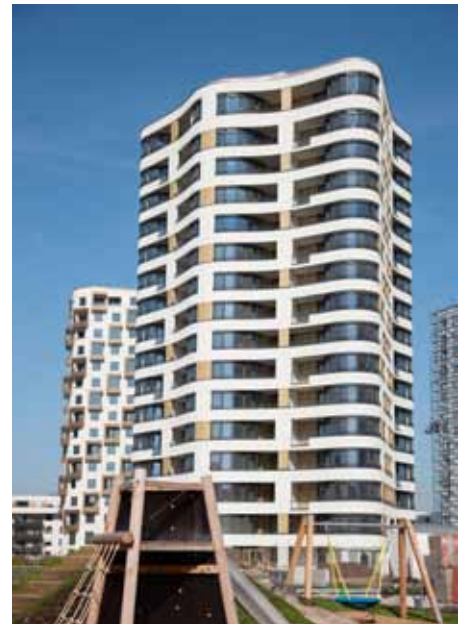
Der Wohnturm „Sternenhimmel“ bietet heute 76 neue Wohnungen.
