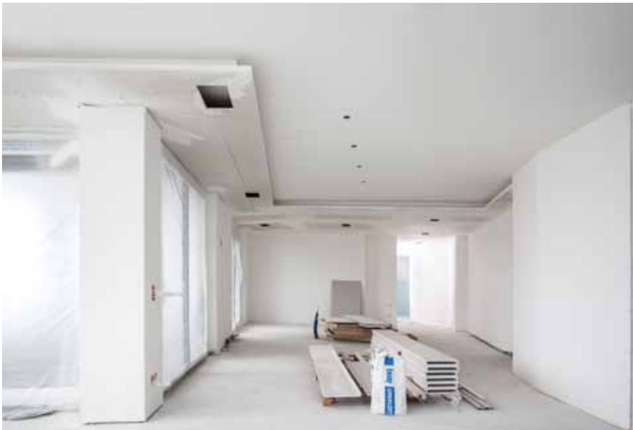
Sondereinbauten wie Deckenfelder oder Lichtvouten wurden aus Formteilen gefertigt.
