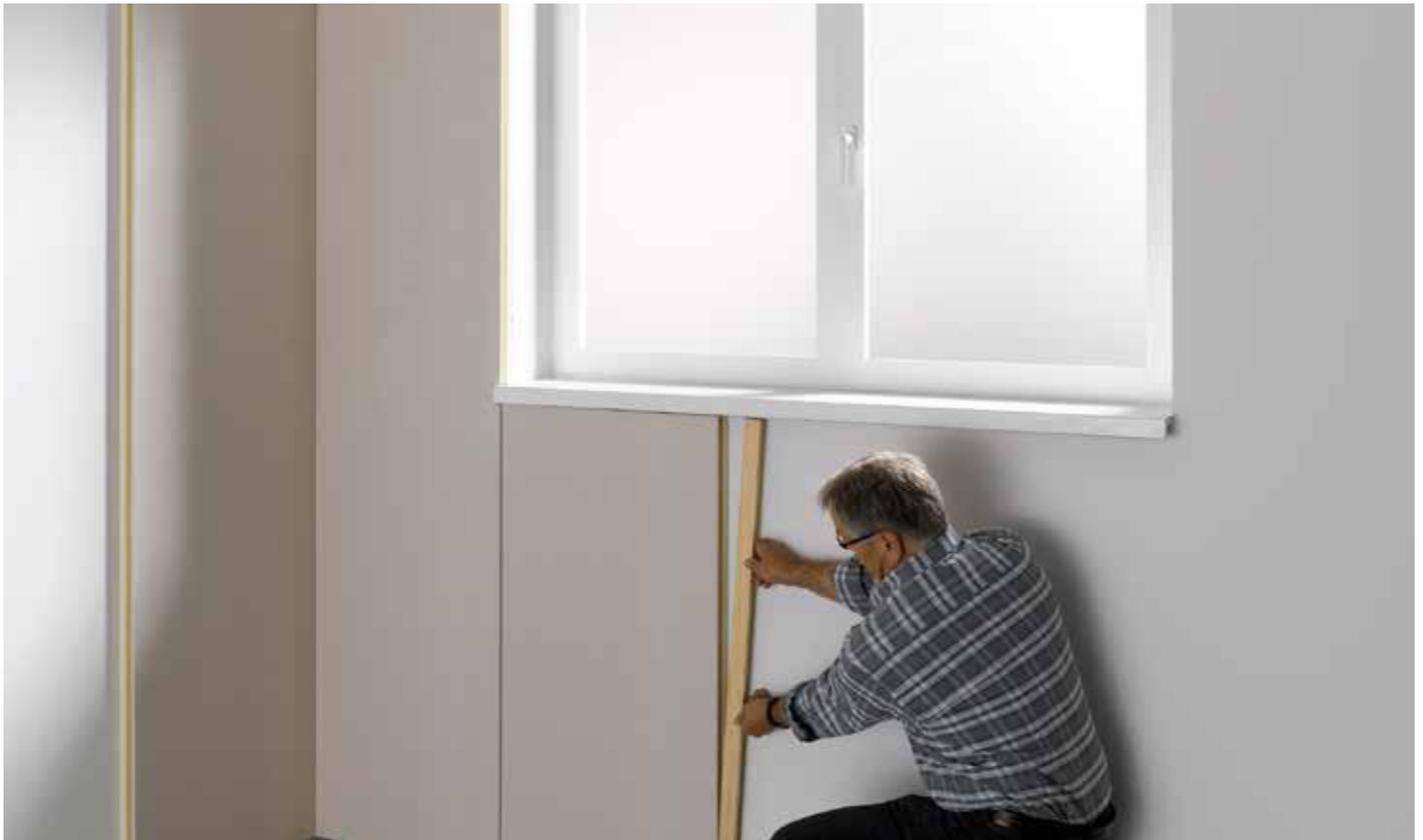
In nur einem Arbeitsgang entsteht eine homogene Wärmedämmung mit streich-, putz- und tapezierfähiger Innenseite.
