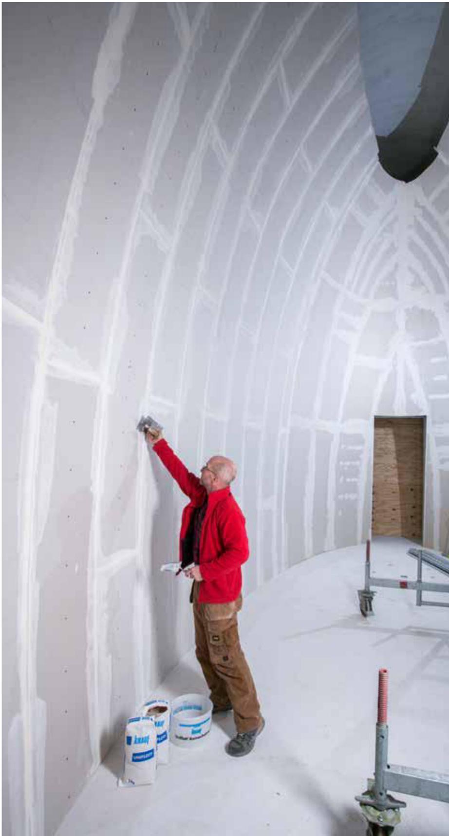
Für die Wände des Andachtsraums wurden vorgefertigte Teile verwendet.
