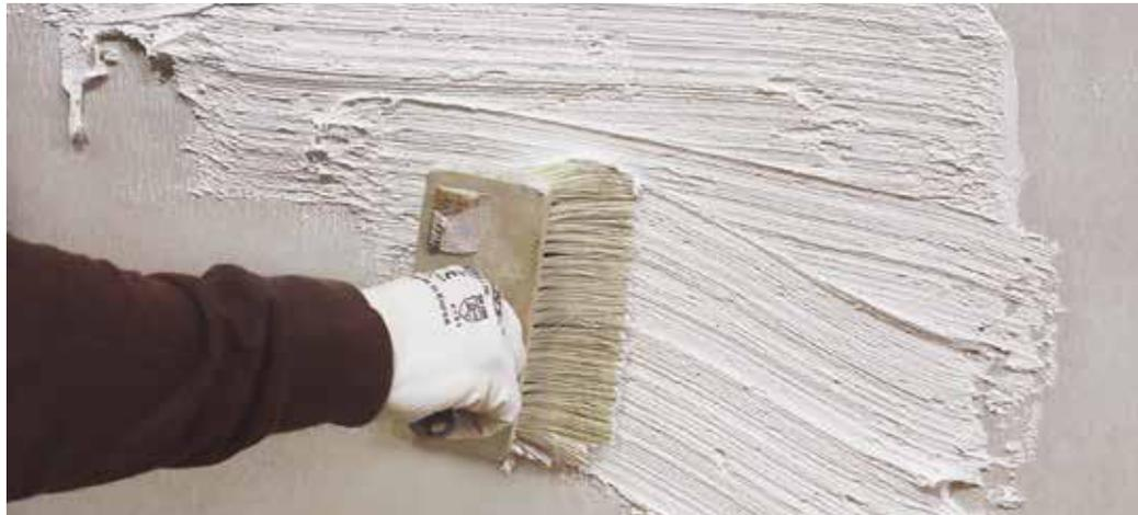
**Die redstone Vivo Vario Antikondensationsbeschichtung ist leicht zu verarbeiten und kann überall dort eingesetzt werden, wo mit Schimmelpilzbildung durch erhöhte Luftfeuchtigkeit gerechnet werden muss.**
