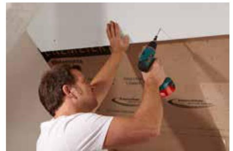
**LINITHERM PAL GK: Dämmverbesserung unter den Sparren bei vorhandener Zwischensparrendämmung. Raumseitig bildet die aufkaschierte Gipskartonplatte einen sauberen Abschluss. Spachteln, streichen, verputzen oder tapezieren – fertig.**
