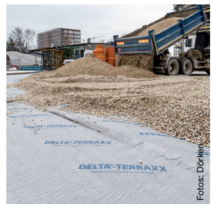
Die universelle Schutz- und Dränbahn lässt sich vielseitig einsetzen, auch auf Flachdächern mit schwerem Oberflächenschutz aus Kies oder unter extensiv und intensiv begrünten Flächen.
