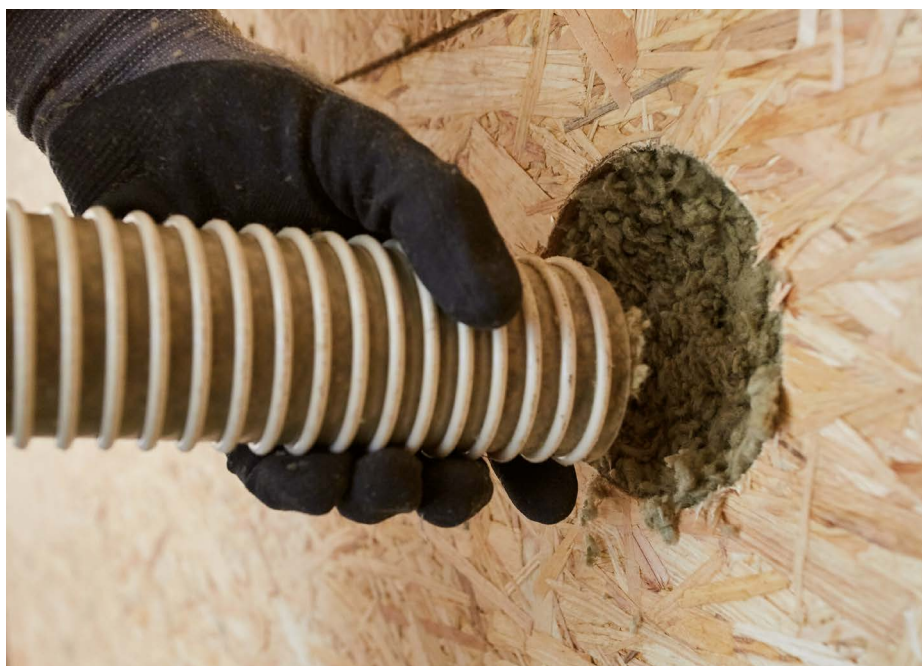
Eine „Fillrock RG Plus“ Einblasdämmung ist als nichtbrennbar A1 klassifiziert und enthält keine Flammschutzmittel oder Borsalze
