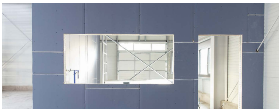
Knauf Diamant steht für schlanke Wandaufbauten mit hohem Schall- und Brandschutz, robusten Oberflächen und hohen Konsollasten
