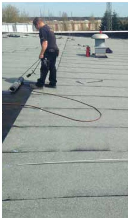
Im linken Bild ist gut die zusätzliche Befestigung mit den SFS-Spezialschrauben zu erkennen. Rechts: Aufschweißen der Sanierungsbahnen.
