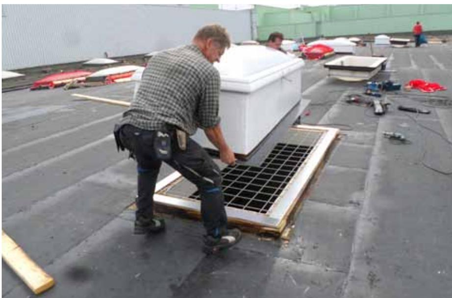
**Oben: Extra vom Schlosser angefertigte Stahlkehlen warten auf ihre Befüllung. Unten: Die neuen Lichtkuppeln werden über der Durchsturzicherung platziert.**
