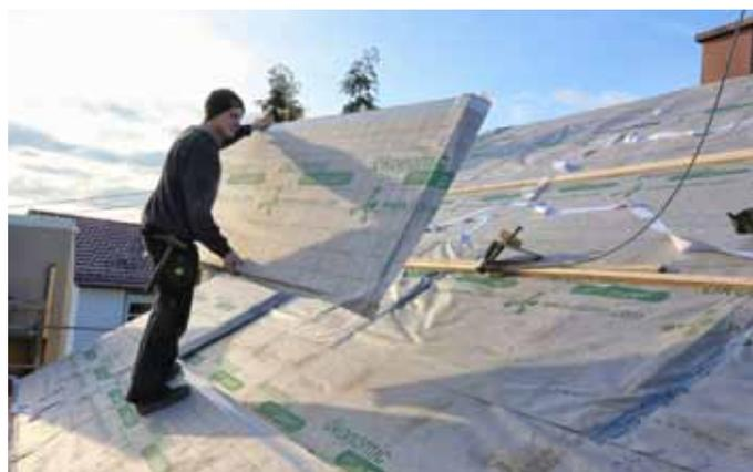
Eignet sich optimal für die Kombination mit einer Zwischensparrendämmung: Das Basisdämmsystem ökonomisch – made by puren.
