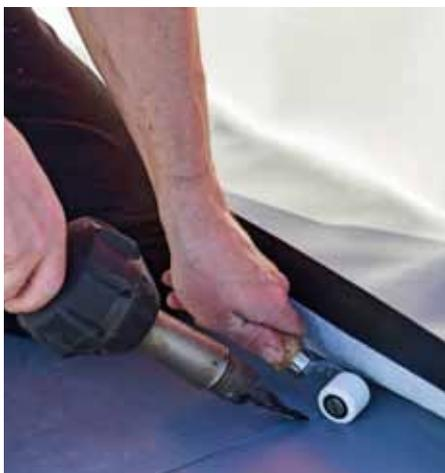
**Gefügt werden die Rhepanol® Dachbahnen mittels Heißluft.**
