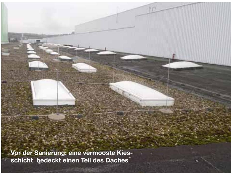
Vor der Sanierung: eine vermooste Kies-schicht bedeckt einen Teil des Daches
