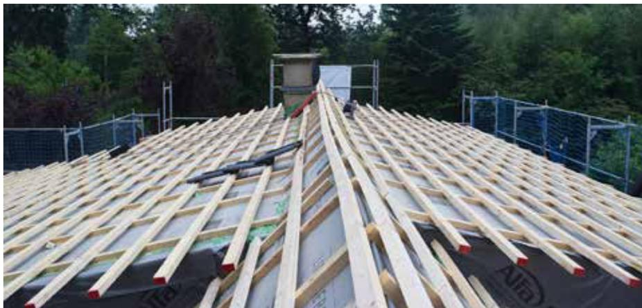
**Aufsparrendämmung als Grundlage: Auf der gesamten Dachfläche des Hauses wurde eine geschlossene Schicht aus Dämmelementen verlegt.**
