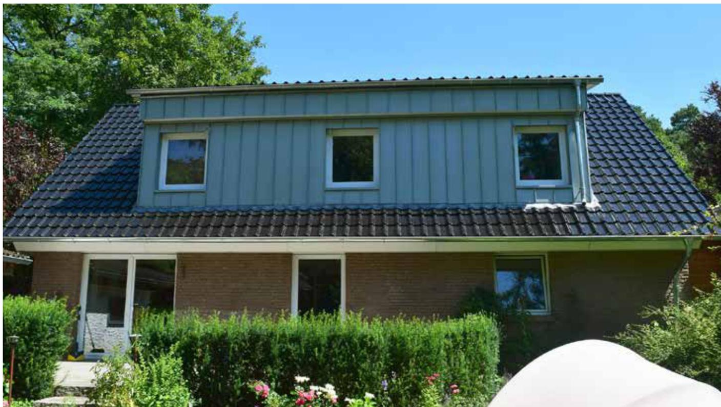
**Nachher:** Durch die energetische Sanierung wurde im Bereich der Dachfläche ein U-Wert von  $0,14 \text{ W}/(\text{m}^2\cdot\text{K})$  erreicht.
