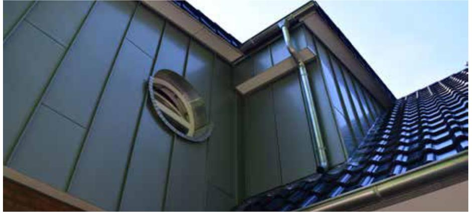
**Das runde Fenster erforderte spezielle Klempneranfertigungen.**
