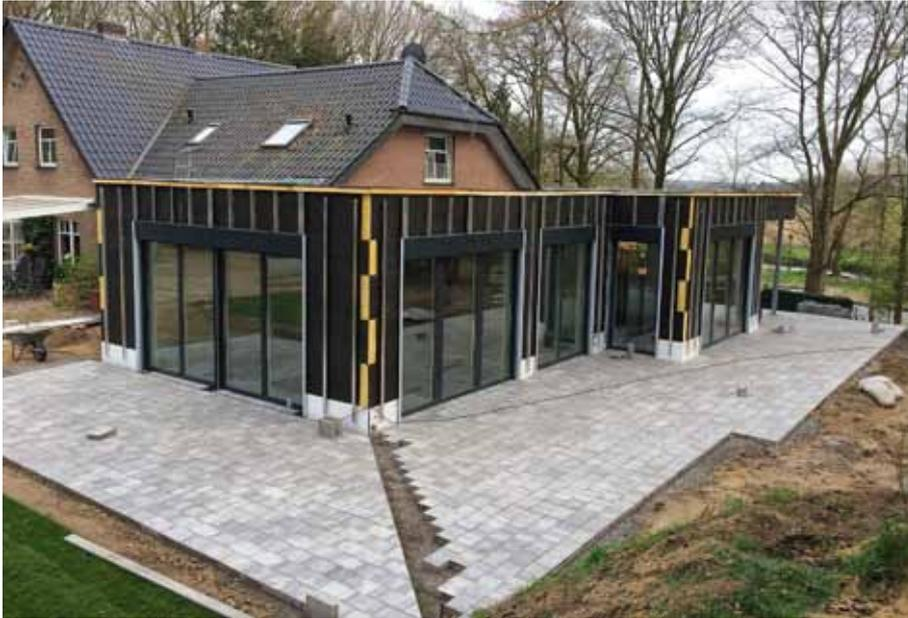
Eine diffusionsoffene Dämmfolie von DÖRKEN schützt das Mauerwerk und bildet die Grundlage für Unterkonstruktion und Dämmung der Fassade.
