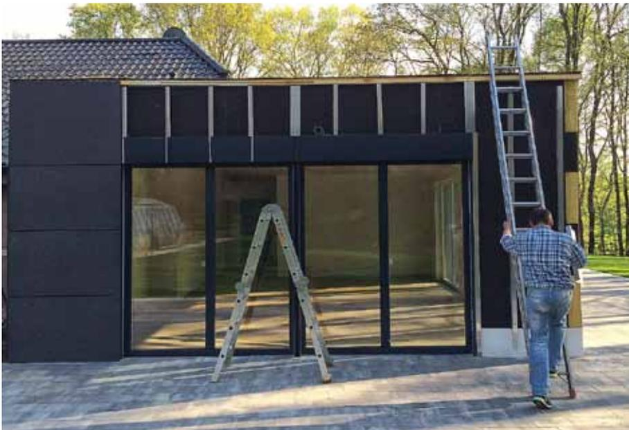
Präzise Handarbeit: Jede Faserzementtafel wird von Hand auf die Unterkonstruktion aus Aluminium geschraubt.
