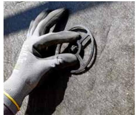
Die diffusionsoffenen „Fixrock“ Fassadendämmplatten von ROCKWOOL sorgen seit vielen Jahren für erstklassigen Wärme-, Brand- und Schallschutz in vorgehängten hinterlüfteten Fassaden. Zusätzliche Vorteile bei der Verarbeitung bringt die Möglichkeit der Ein-Dübel-Befestigung. Ein spezieller zweiteiliger Dämmstoffhalter aus hochwertigem Kunststoff sorgt für die Lagesicherung der Dämmplatten.
