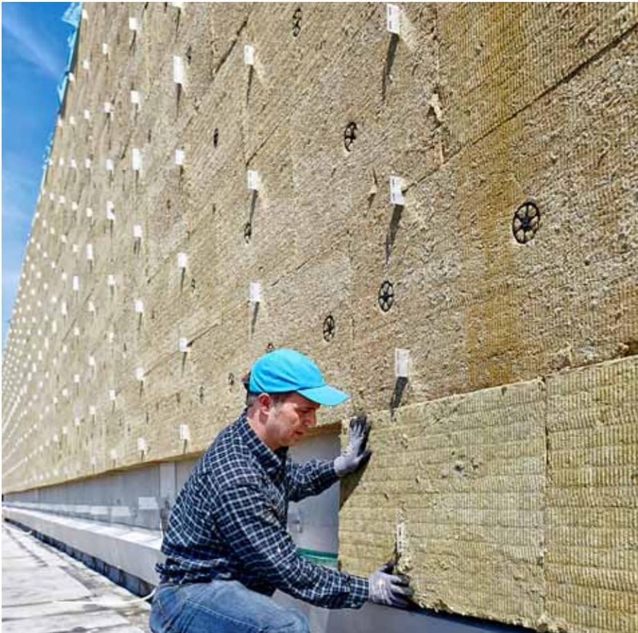
Die bewährten „Fixrock“ Fassadendämmplatten für die vorgehängte hinterlüftete Fassade sind jetzt auch in 200 mm Dicke erhältlich.
