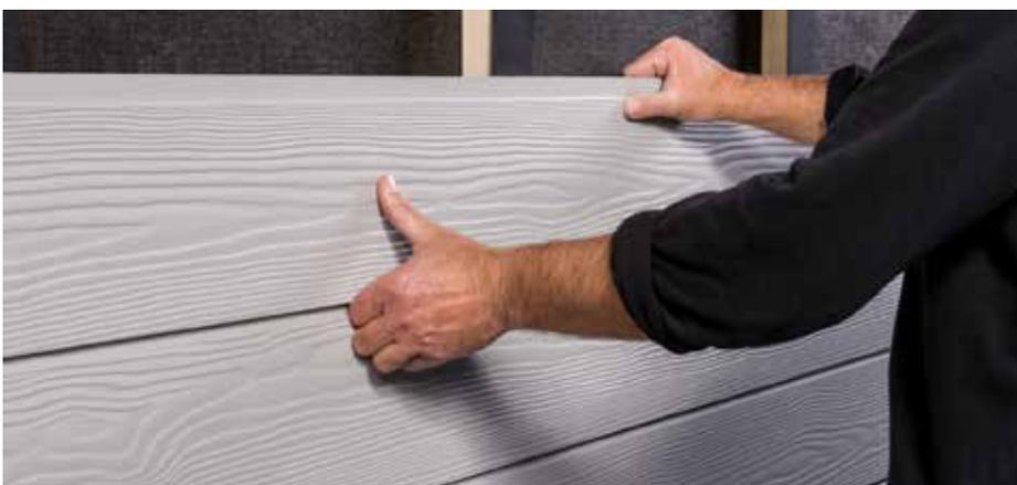
Auf der Holzunterkonstruktion wird das Faserzementpaneel CEDRAL click
